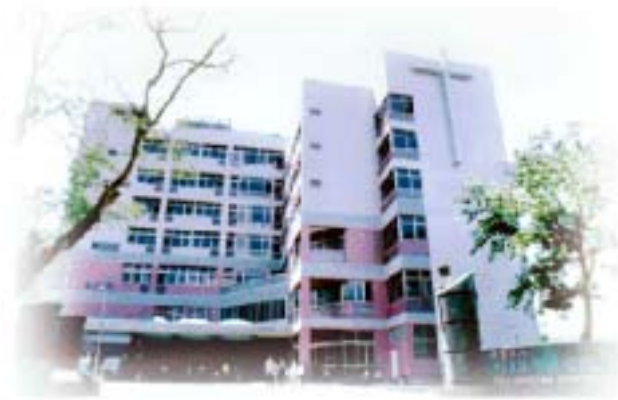
工程名稱：埔里基督教醫院新建工程 工程內容：空調工程 800RT(278 床)
