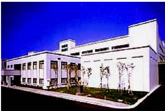
工程名稱：食益補(白蘭氏雞精)彰濱廠 空調工程 工程內容：無塵室工程 CLASS 100K、空調工程 100RT、儲冰系統 250TON/HR
