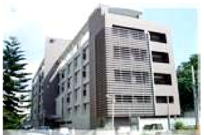
工程名稱：進階生物科技開發中心水電消防 空調蒸汽電信及門禁監控設備工程 工程內容：無塵室工程 CLASS 10K、機電工程 空調工程 510RT、蒸氣系統工程
