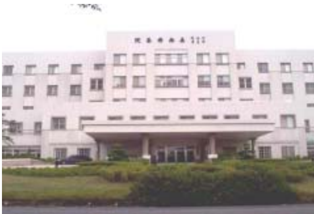
工程名稱：省立嘉南精神科醫院新建空調工程 工程內容：空調工程 1200RT(400 床)
